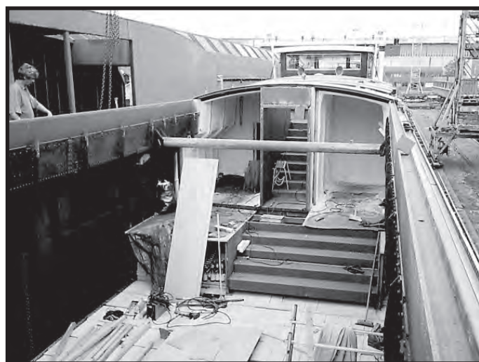
Chantier naval Meuse et Sambre, gros bordel, restons zen!! Août 2005
